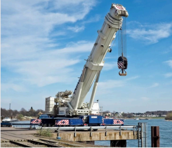
Grúa con polea
